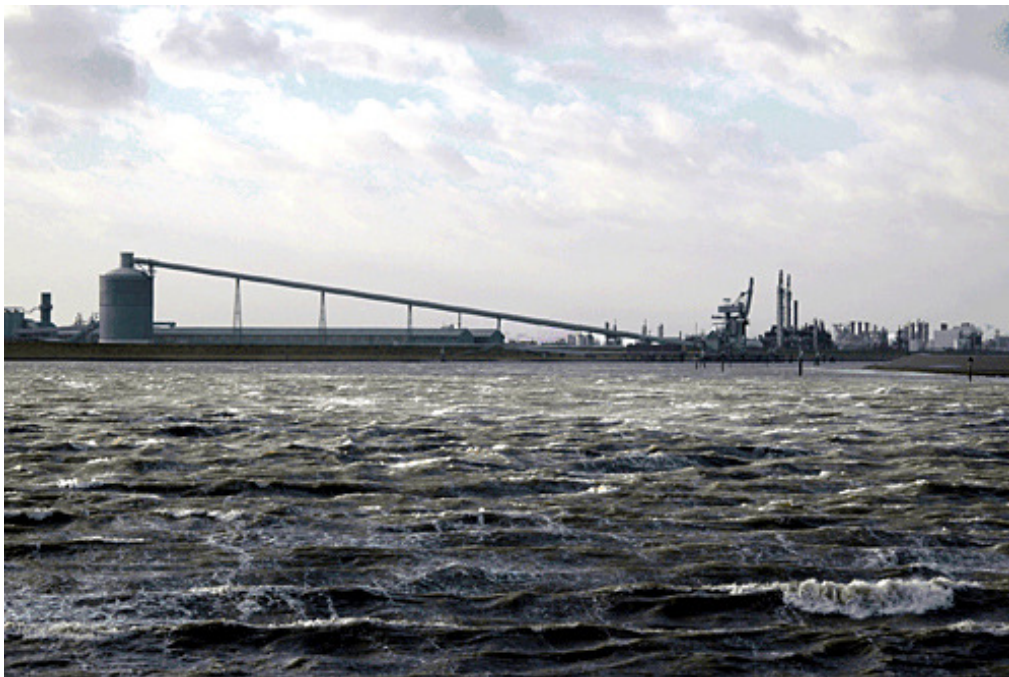
Figuur 2. De laadsteiger van Aldel gezien vanaf het water
